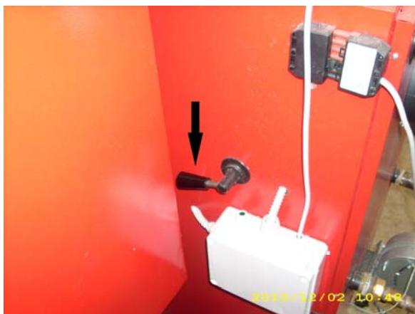
Рисунок 7. Положение ручки клапана «РАБОТА»
