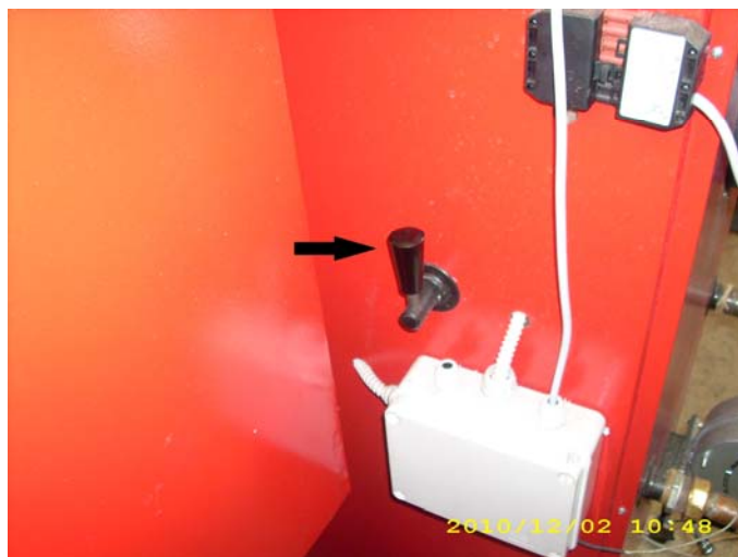
Рисунок 9. Положение ручки клапана «ПОДЖИГ»
