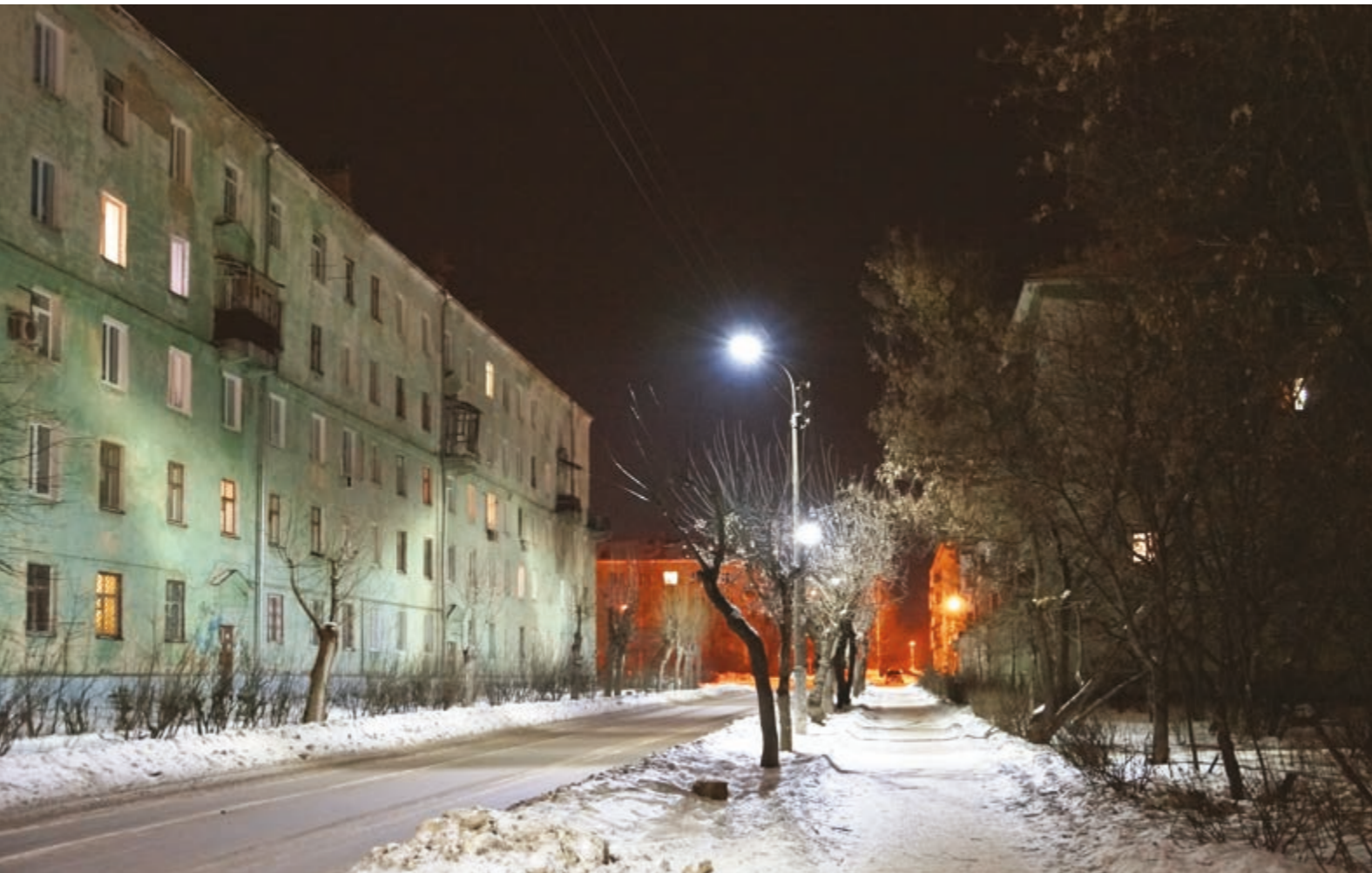
Освещение городской застройки светильниками VIKING (на заднем плане светильники с лампами ДНаТ)
