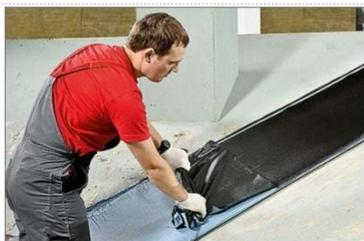
С одной части подкладочного ковра удаляется защитная пленка
