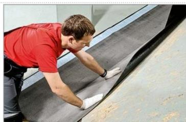
Эта часть подкладочного ковра приклеивается к основанию. В момент приклеивания следует аккуратно разглаживать полотно, избегая образования складок и неровностей
