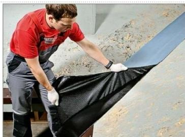
Затем таким же образом удаляется пленка со второй половины подкладочного ковра
