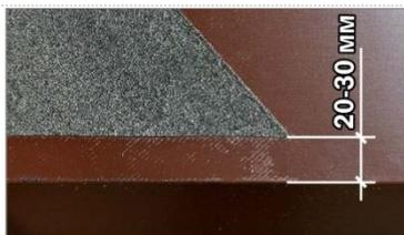
На карнизном свесе самоклеящийся подкладочный ковер укладывается так, чтобы до перегиба карнизной планки остался зазор 20-30 мм
