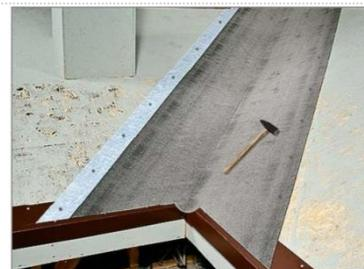
При температуре ниже +5 °С рекомендуется дополнительно закреплять подкладочный ковер кровельными гвоздями с широкой шляпкой
