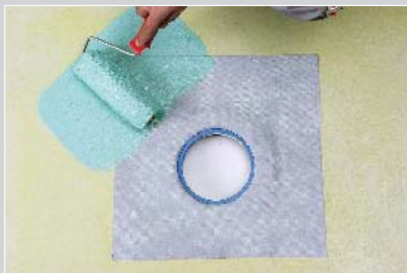
Герметизация сливного трапа пластырем LITOBAND P
