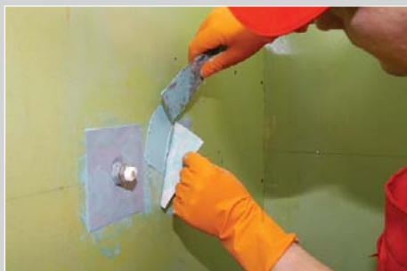
Герметизация выпуска трубы пластырем LITOBAND S
