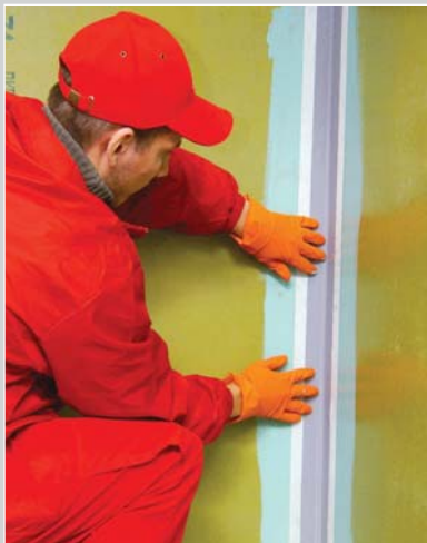
Герметизация стыка "стена-стена" лентой LITOBAND R
