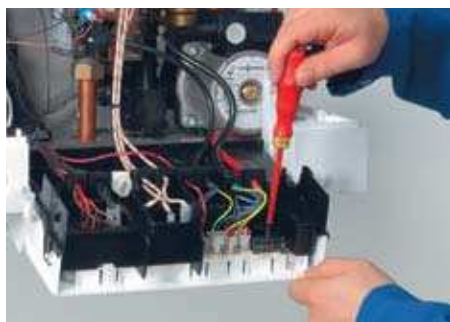
3. Подключение электрических присоединений
