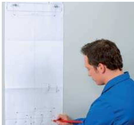
1. Предварительная разметка с помощью монтажного шаблона
