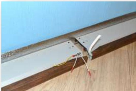
5. Ответвителями соединить свободные концы нагревательного элемента и заземления с разделанным участком магистрального кабеля (при помощи плоскогубцев).
