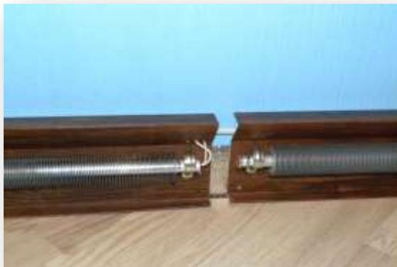
7. Соединить задние панели плинтусов при помощи пластикового соединителя, приобретаемого дополнительно.
