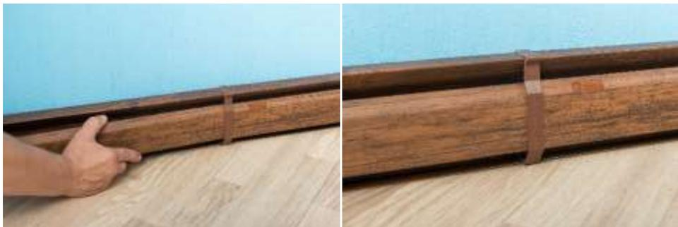
11. С боков плинтуса оденьте торцевые элементы и зафиксируйте их при помощи саморезов.
