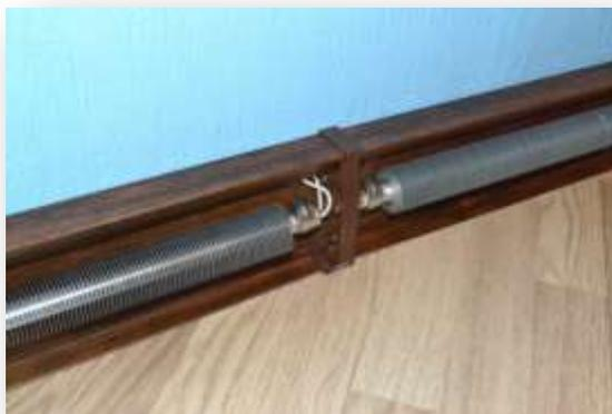
8. Задняя панель плинтуса крепится саморезами к стене.
