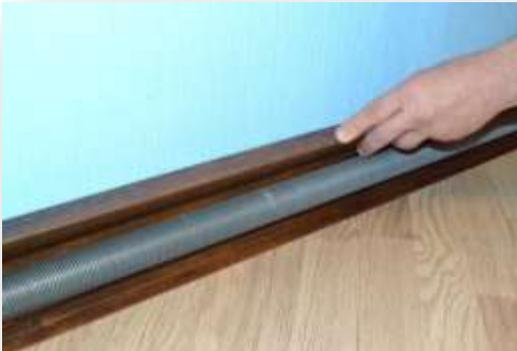
3. Между стеной и задней частью корпуса теплого плинтуса Орион устанавливается теплоизоляционная лента.
