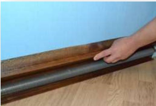
4. В верхней части задней панели плинтуса прокладывается магистральный кабель (в комплект поставки системы отопления не входит) и зачищается верхний слой изоляции в месте присоединения нагревательного элемента длиной 70 мм.
