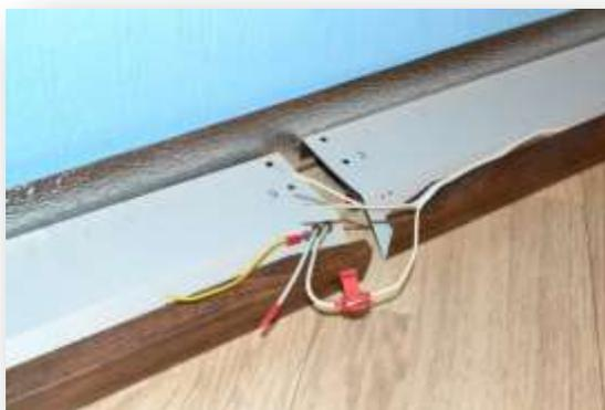
6. Убрать соединенные концы кабелей в нишу в верхней части задней панели плинтуса.
