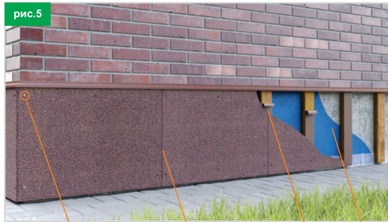
Отверстие для крепежа: отступ 70 мм от левого и 50 мм от верхнего краев панели
